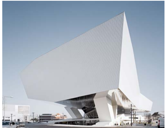
Für den Außenraum wurde eine Mastleuchte der Olivio-Akzentleuchtenserie von se'lux weiterentwickelt, um die Straßenzufahrt und die Terrassenbrüstung zu beleuchten
